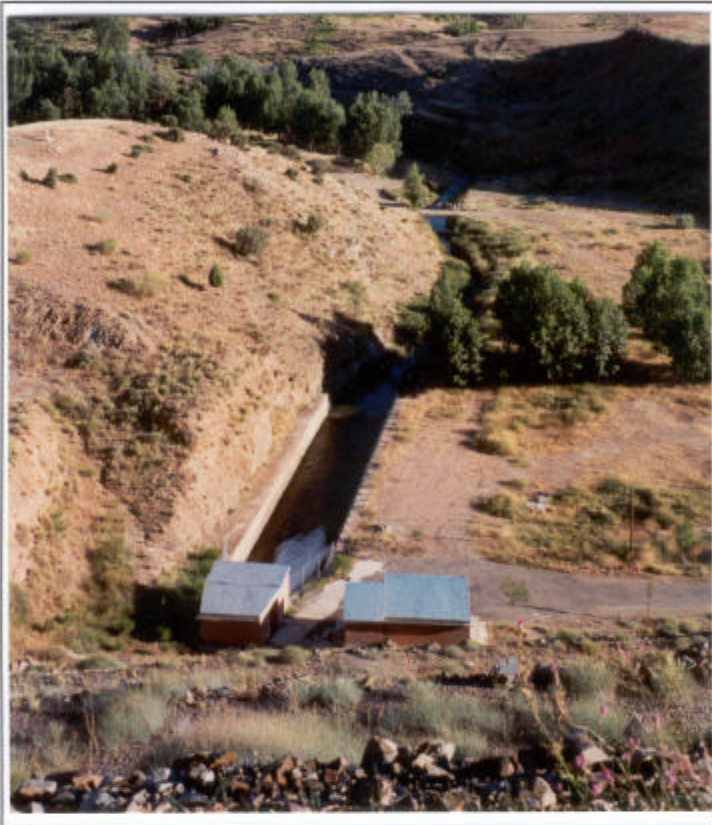
Canal de desagüe de la presa de Maidevera.
