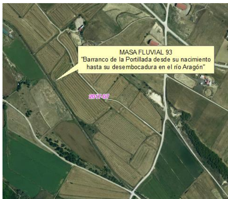
Figura 21. Cambio de naturaleza (de natural a muy modificada) de la masa tipo río ES091MSPF93 en el Barranco de la Portillada (detalle del tramo final, rectilíneo y canalizado).
