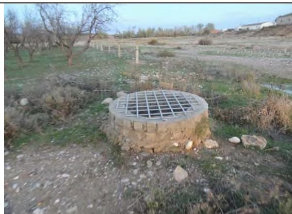
Pozo de 3,65 m de profundidad en el aluvial en Vinaceite en las inmediaciones del puente de la carretera. Seco al igual que el cauce.
