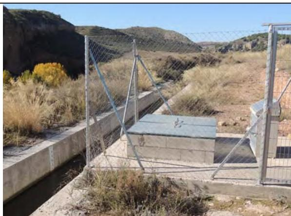
Estación de aforos de la Comunidad de Regantes en la acequia de Belchite. Dispone de lectura automática mediante comunicación telefónica.
