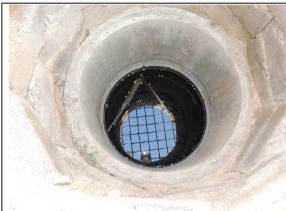
Pozo de 3,65 m de profundidad en el aluvial en Vinaceite en las inmediaciones del puente de la carretera. Se miden 2,24 m de columna de agua. El aluvial se ha llenado.
