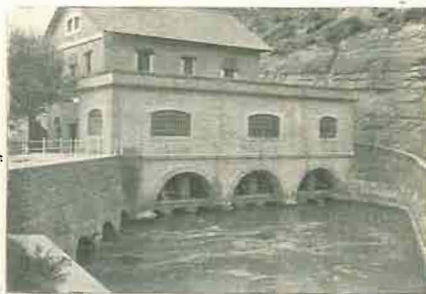
Compuertas de entrada del Canal de Urgel, protegidas con INERTOL.
