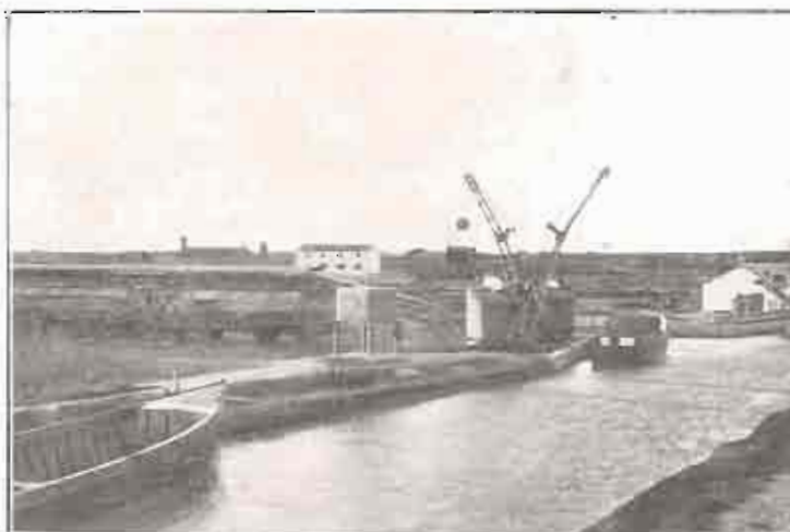
CANAL IMPERIAL DE ARAGÓN: EL ENBARCADERO DE ORRÉN
