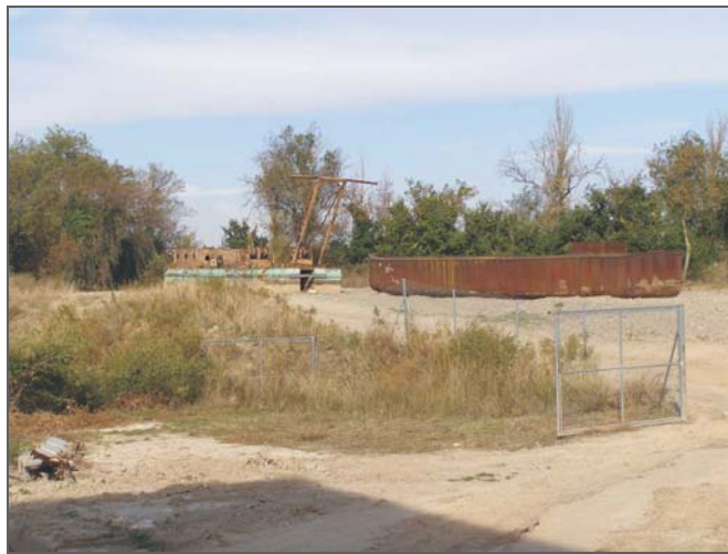
Antiguas embarcaciones de dragado y trasporte del canal abandonadas.
