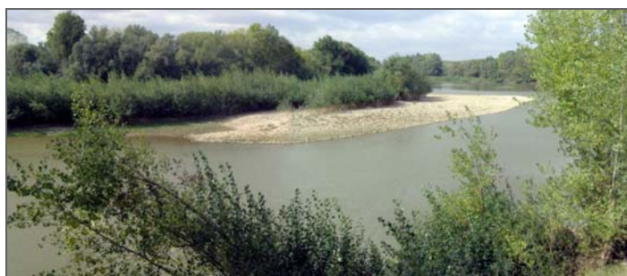
Ebro en San Adrián, el río golpea la margen izquierda socavando la escollera, mientras que en la margen derecha el río acumula gravas.
