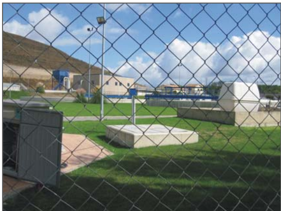
EDAR de Miranda de Ebro
