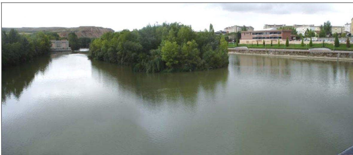
Vista panorámica del río Ebro desde el puente de piedra de Logroño, al fondo sobre la margen izquierda se observa la central hidroeléctrica de Logroño.
