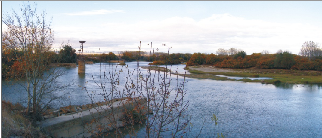
Río Ebro desde Alcalá de Ebro. El río se ha desplazado hacia esta localidad y por ello se han instalado espigones y escolleras de protección. Actualmente se está planteando la posibilidad de hacer canales de aguas altas para mejorar la protección en este tipo de puntos.
