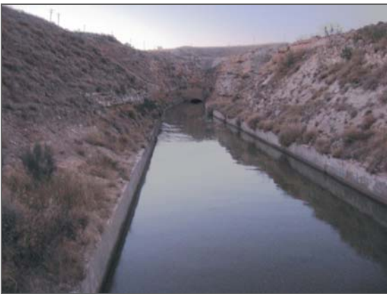
Salida del túnel de derivación a la CH Sástago II
