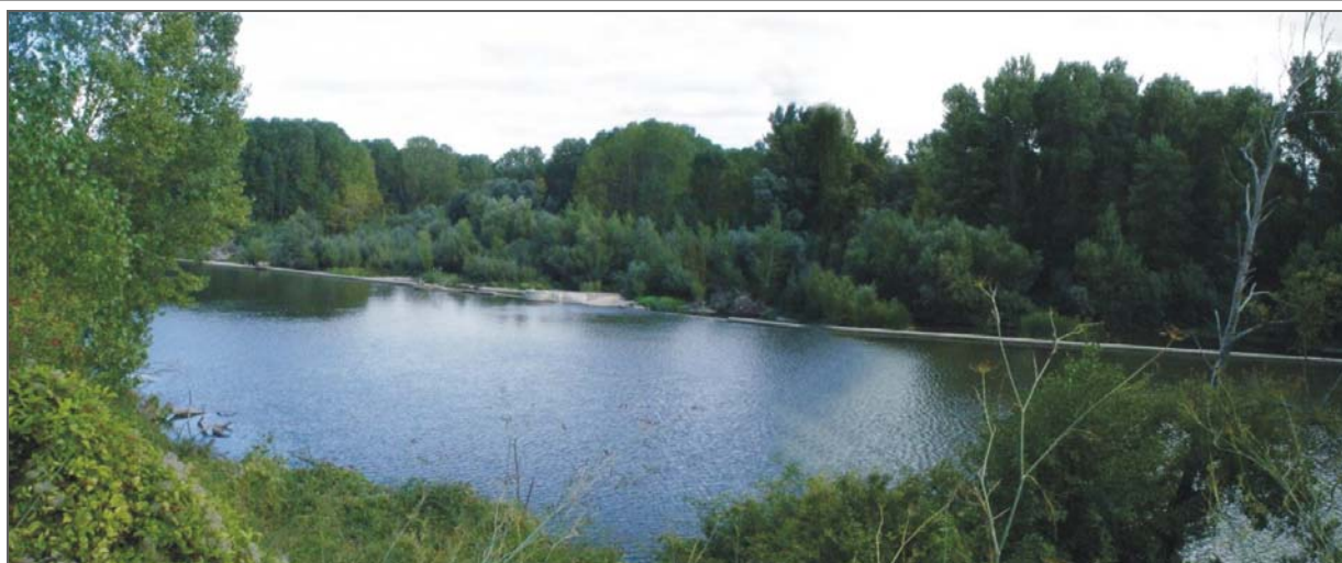
Azud central hidroeléctrica Labastida
