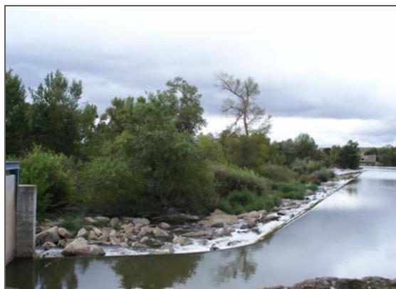
Azud de la central hidroeléctrica Assa [Lanciego]
