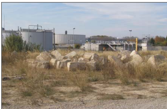
EDAR de Tudela. Utiliza una tecnología de Lecho bacteriano. Está al lado del azud de la mejana de la Mosquera.
