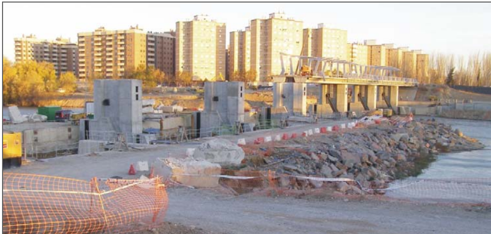
Obras del azud del Ebro en Zaragoza
