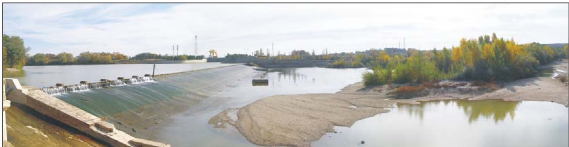
Azud de Pignatelli en El Bocal, termino municipal de Fontellas. No tiene escala de peces. En primer término, paso de almadías. De este azud sale el Canal Imperial de Aragón y en canal de la CH de Belver, con tres turbinas de 300 m 3 /s cada una. La central no turbinaba en verano.
