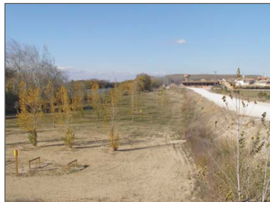
Carretera Pradilla de Ebro – Boquiñeni. Ha sido construida por AquaEbro. Esta carretera actuará como mota de protección de Padilla.
