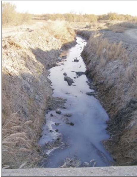
Canal de conducción de las aguas residuales de El Burgo de Ebro y su zona industrial, actualmente sin tratamiento.
