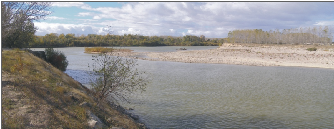
Meandro protegido con escollera sobre la margen derecha del río Ebro en las inmediaciones de Utebo. Desde donde se hace la foto se han instalado unas mesas y bancos para su uso por turistas y senderistas.
