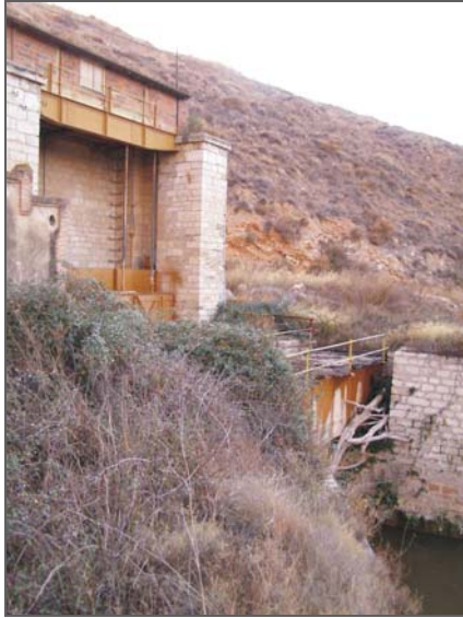
Entrada del túnel del canal de la central hidroeléctrica de Sástago II.
