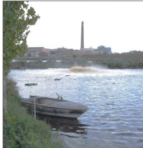
Balsa de depuración de la papelera de Miranda de Ebro
