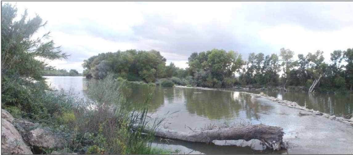
Presa de Santillana, recoge aguas para regadíos, azud antiguo.
