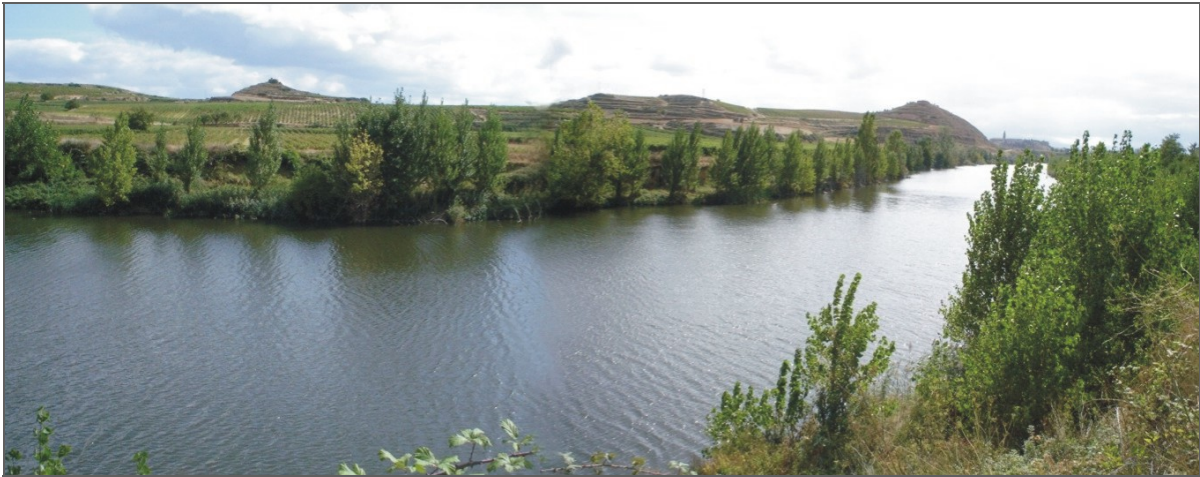
Río Ebro aguas arriba del puente medieval de Briñas. En avenida hay riesgo de taponamiento del puente.
