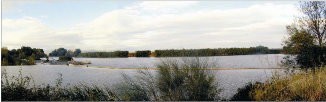
Azud de C.H de Machín y la comunidad de regantes de Ardiel y Rincón de Soto y Alfaro (en la margen derecha con un caudal de 3-4 m 3 /s) y otra acequia por la margen izquierda.
