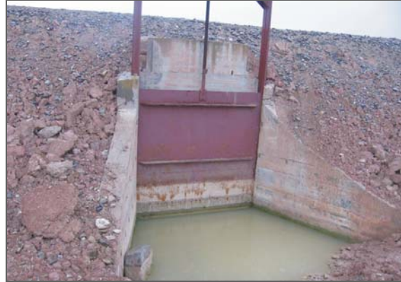
Tajadera de escorredero de riego que desemboca en el barranco Las Limas
