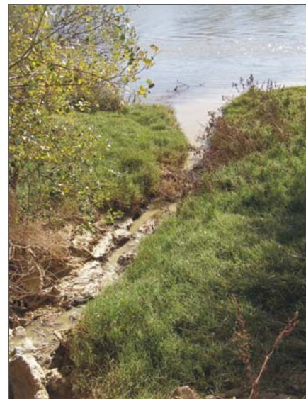
Punto de vertido de Remolinos, sin tratamiento.
