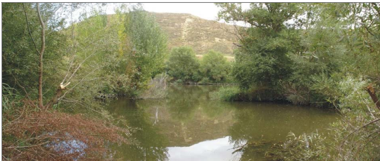
Antigua zona extracción de áridos no restaurada en el Recodo de Gimileo. La extracción intensiva ha hecho que el nivel freático se haga más superficial y ha incrementado el riesgo de inundaciones en la zona.
