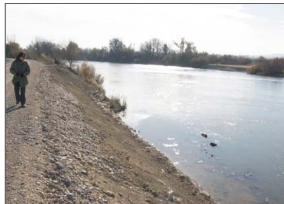
Estabilización de taludes realizada por la CHE sobre la margen izquierda del río en el termino de Osera de Ebro
