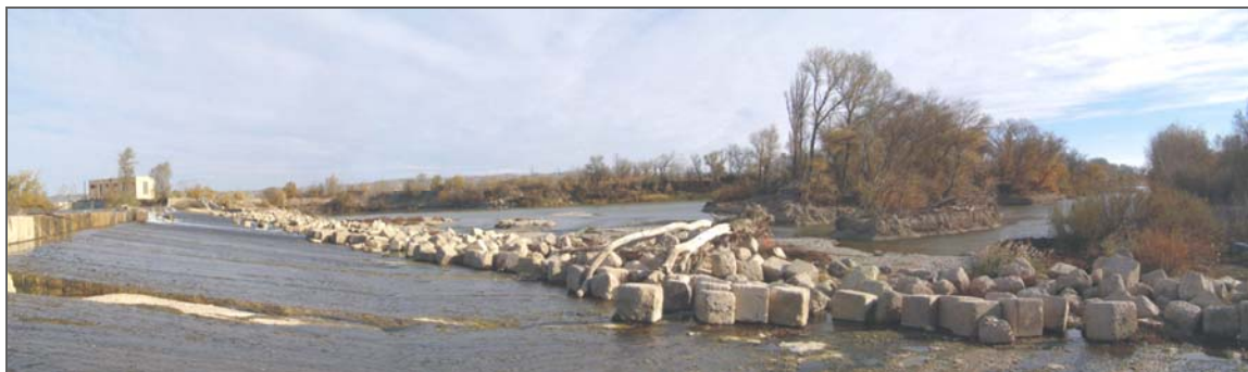
Vista de la presa de la CH de Pina, donde se deriva agua a las acequias de Fuentes de Ebro en la margen derecha y la acequia de Quinto en la margen izquierda. En el momento de la visita se estaba limpiando y saneando la zona de aguas abajo del azud. La presa tiene escala de peces.
