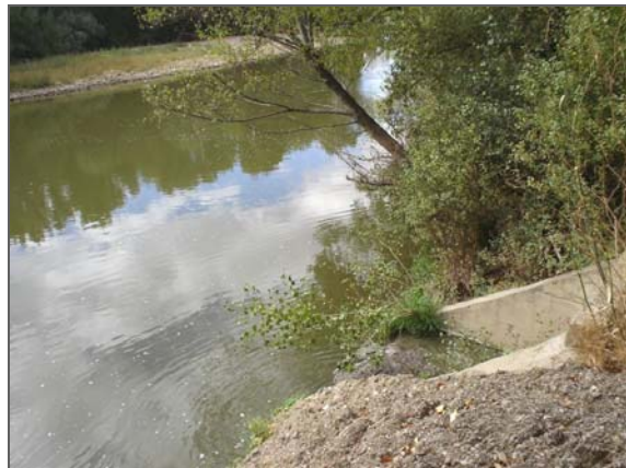
Vertido aguas residuales sin tratar el centro comercia y hotel Las Cañas en el termino de Viana
