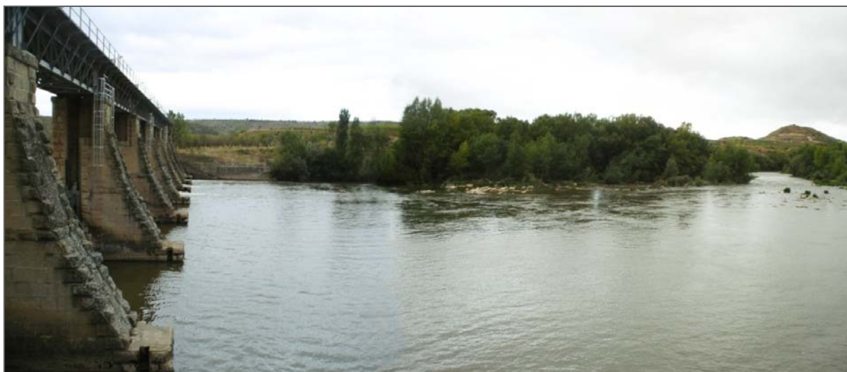
Azud central hidroeléctrica de El Cortijo. En algunas ocasiones se han producido quejas por deficiencia de caudal aguas abajo de la central . Esta central funciona a saltos, alterando el régimen del río aguas abajo de la misma. La modulación de caudal que produce la central se llega a percibir hasta Castejón. Recientemente el SAIH ha instalado una estación de aforo en el canal.
