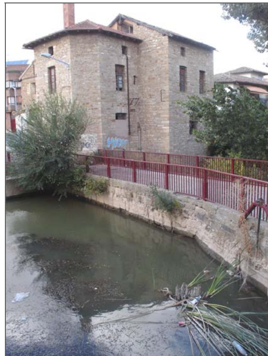
Ebro en Lodosa, punto de inundación en el 2003. Molino sin uso
