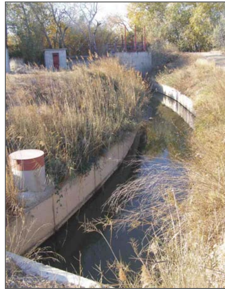
Acequia de Pina sobre la margen izquierda del río Ebro, toma sus aguas del azud de la presa del mismo nombre. En primer término de la foto se puede observar un limnógrafo.
