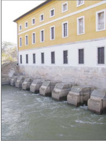
Casa de compuertas del Canal Imperial en el Bocal.
