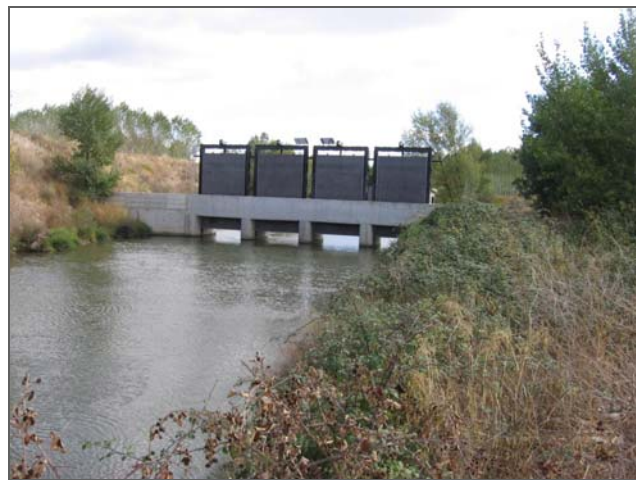
Canal de derivación de la central hidroeléctrica de Mendavia
