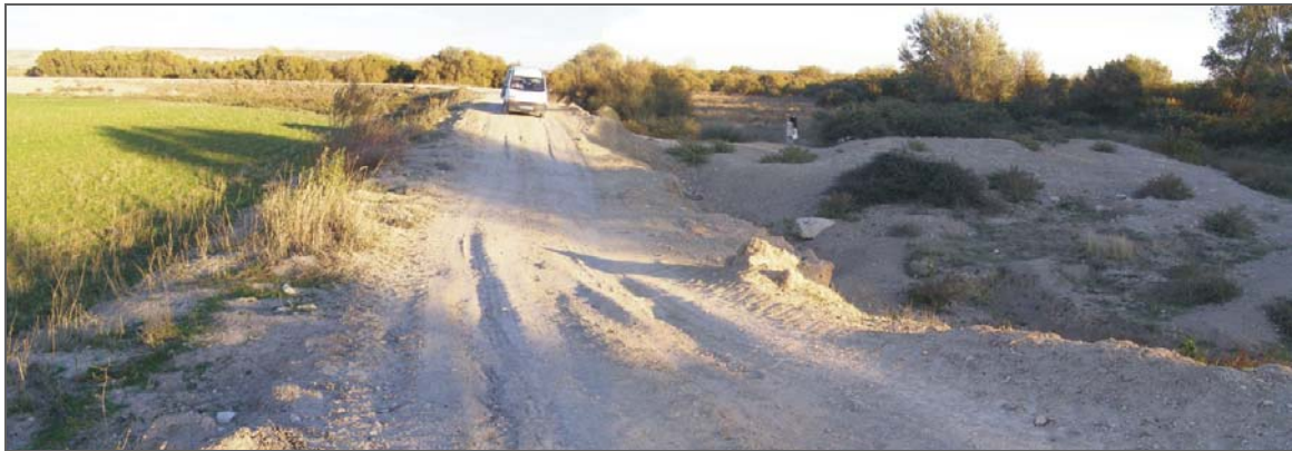
Punto de retorno del agua desde las fincas hasta el río en las avenida de 2007 sobre la margen izquierda en el termino de Cortes
