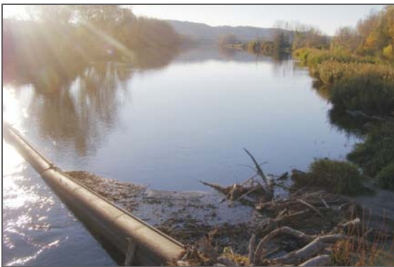
Azud de la CH de la Ribera, deriva el caudal total en verano, afectando la continuidad del río
