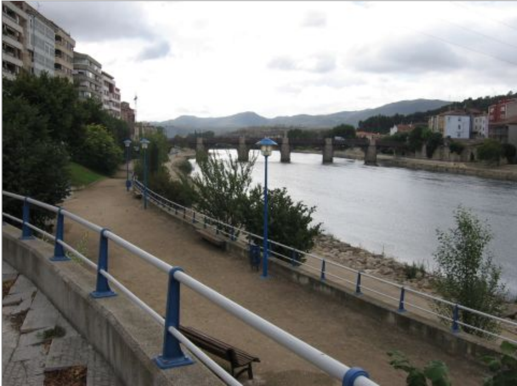
Figura 2.50: Tratamiento de la ribera en el río Ebro a su paso por Miranda de Ebro
