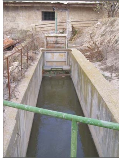
Acequia voluntaria de la comunidad de regantes de la Acequia del Molino (CR de Gelsa)
