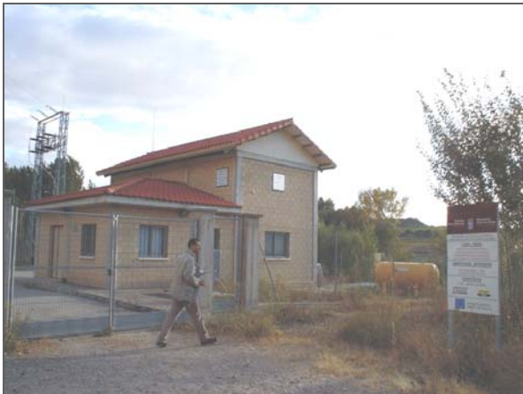
Caseta de bombeo para balsa de regadíos de Baños de Ebro, zona anegada en la avenida de 2003
