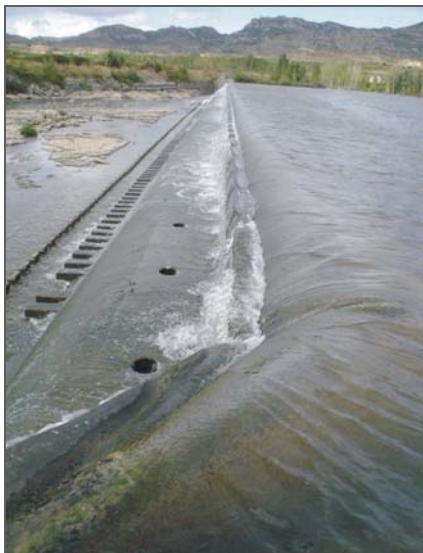
Central hidroeléctrica de Suso. Dispone de un sistema de compuertas móviles, constituido por una membrana tubular de caucho colocada a través del río para elevar el nivel del agua.
