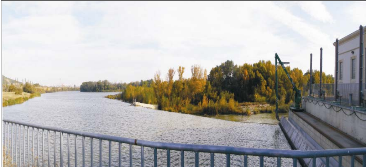
Central hidroeléctrica de Tudela y acequia de la comunidad de regantes de Arquetas, Lodaes y Mosquera
