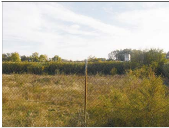
Pozos de abastecimiento de Tudela. Tiene un vallado de protección. Tudela se abastece de estos pozos, de una toma directa del río y de otra toma del canal de Lodosa. Está previsto que en un futuro tome del canal de Navarra.
