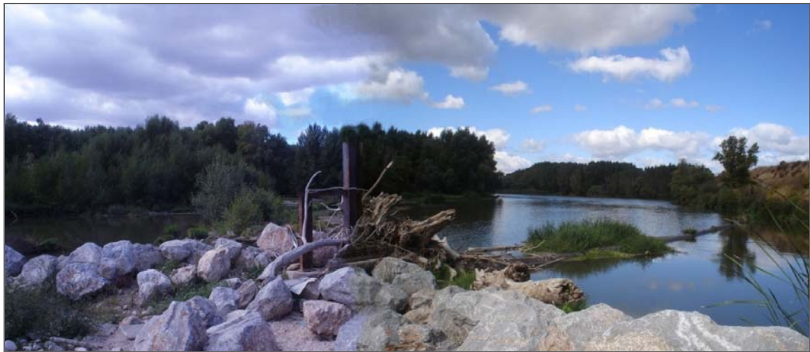
Azud de la central hidroeléctrica de Mendavia
