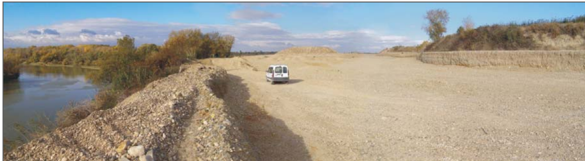
Extracción de áridos en el paraje Las Canteras en Tauste, ubicada sobre el cortado de la margen Izquierda. El río está desmontando puntualmente el talud. Cabe plantear en este punto una actuación para evitar la erosión de la margen izquierda mediante la creación de un canal de aguas altas en la margen derecha.
