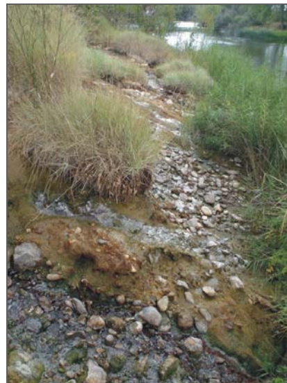
Infiltraciones de lixiviados de una de las balsas de la planta de tratamiento de la papelera de Miranda de Ebro por estar localizada en zona de D.P.H.
