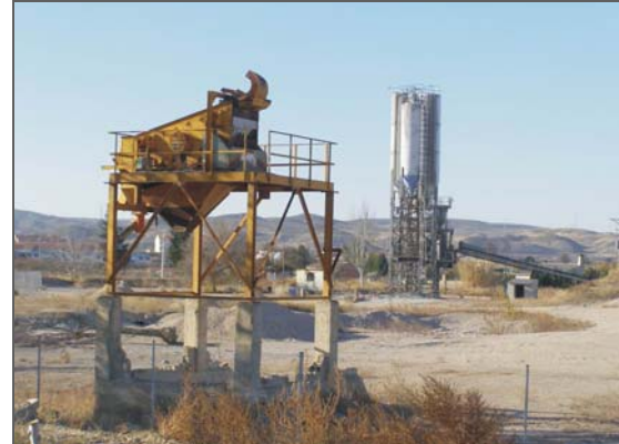
Maquinaria de extracción de áridos abandonada en zona de D.P.H en el termino de el Burgo de Ebro.
