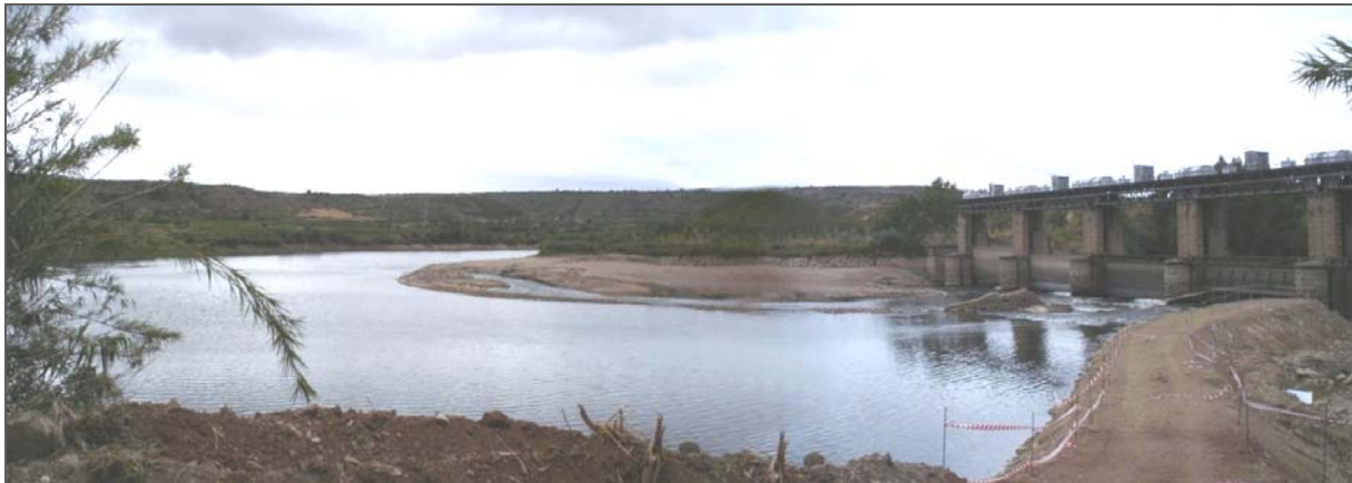
Azud central hidroeléctrica de El Cortijo
