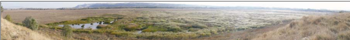
Soto de los Tetones (110,4 ha). Terrenos adquiridos por el Gobierno de Navarra para la restauración del soto natural en la margen derecha del río Ebro a su paso por Tudela, con eliminación de 3 tramos de mota de defensa, eliminación de acequias y caminos y subsolado y gradeo de 70 hectáreas de terreno.
