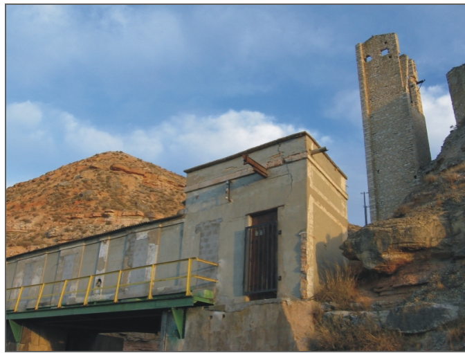
Compuerta del canal de derivación de la CH Sástago I
