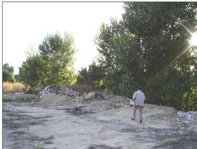
Antiguo vertedero clausurado en el término de Torremontalbo. Sin embargo se siguen depositando escombros.
