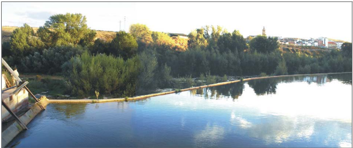
Central hidroeléctrica de Elciego, no hay cumplimiento del caudal ecológico
