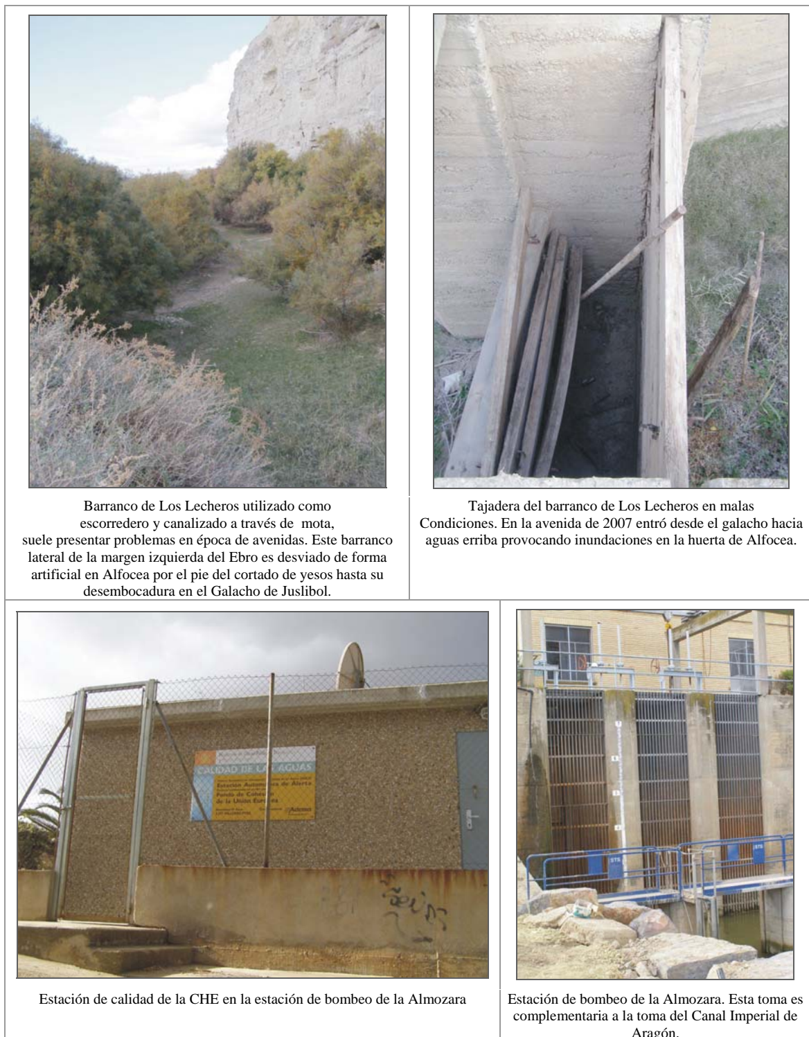
Figura 3.39 (Continuación): Fotos representativas de las características y problemas del eje del río Ebro desde el río Jalón hasta el río Huerva.
