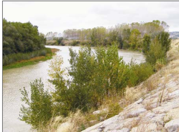
Río Ebro en Soto Aislado, punto crítico en época de avenidas debido al denso soto de la margen derecha que impide la laminación del flujo.
