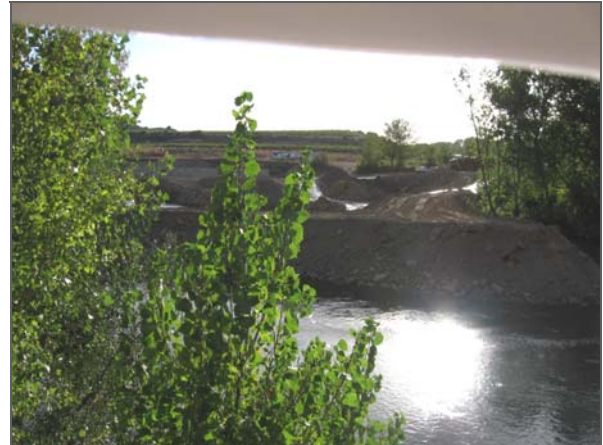
Construcción de la central hidroeléctrica Río Nuevo.
