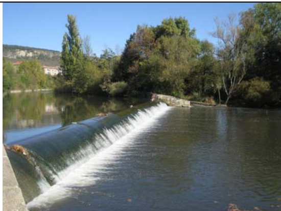
Azud de San Pedro. Deriva agua por margen derecha por un canal hoy en día integrado en el parque del Puente Viejo de San Pedro pero sin uso hidroeléctrico
