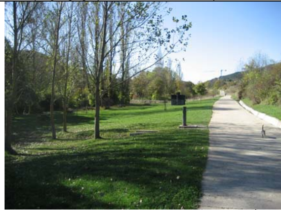
Parque fluvial del Arga. Comienzo a la altura de Erotz. Áreas acondicionadas para la afluencia de paseantes. Paralelo al paseo, en este tramo discurre el colector de aguas residuales de la comarca de Pamplona hasta la depuradora de Arazuri
