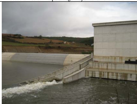
Primer plano de la presa, en el que se puede apreciar la escala de peces
