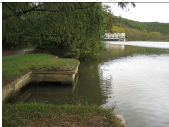
Toma de agua de la Comunidad de regantes de Campollano, en la presa de Sarriá II. Esta agua es conducida a un depósito y desde allí se utiliza para riego mayoritariamente a manta
