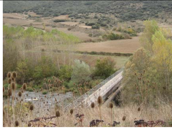
Cruce de la canalización de aguas para el abastecimiento de Pamplona procedentes del Manantial de Arteta después de ser tratadas en la potabilizadora con la carretera NA-7010
