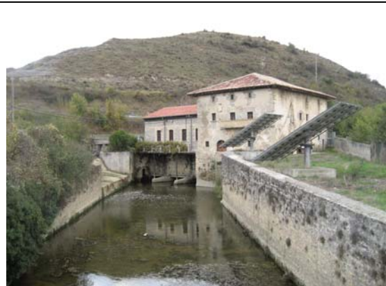
Central de Ibero y comienzo del canal de la central de Echauri que devolverá las aguas al río Arga
