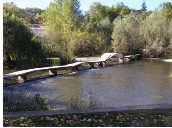
Pasarela peatonal sobre el río Arga. Las pasarelas fueron construidas para facilitar las comunicaciones del cada vez más populoso barrio de la Magdalena con Villava y Burlada. Hacia los años 50, consistían en hileras de bloques de hormigón separados entre sí, sobre los que se colocaban tabloncillos de madera para facilitar el paso. Sin embargo, las tablas se solían llevar el río en sus crecidas, por lo que los viandantes cruzaban el río saltando de bloque en bloque, tal como inmortalizó el cineasta Montxo Armendáriz en su película Secretos del corazón. En el año 2000 fueron sustituidas por las pasarelas actuales, más seguras pero probablemente con menos encanto.
