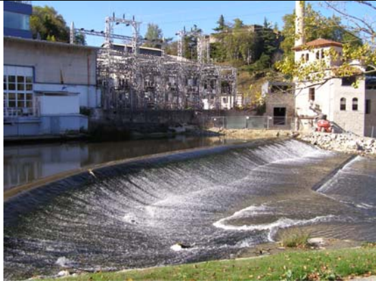
Azud del molino de Caparroso y obras de conversión del mismo en Escuela Municipal de Piragüismo. Estas obras arrancaron a finales de 2007 y se prolongarán durante todo 2008. Con estas actuaciones se dará por concluida la segunda fase del Plan Integral de los Ríos de Pamplona (2003-2008).
