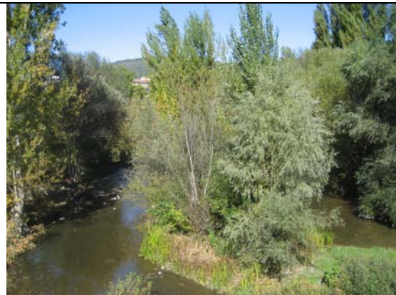
Zona aguas arriba del Puente Viejo de San Pedro en que las acumulaciones de áridos han sido colonizadas por vegetación.
