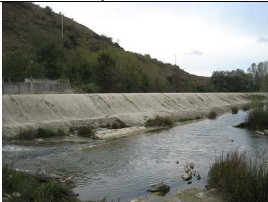
Azud de las centrales de Ibero y de Echauri. No dispone de escala de peces. Habría que asegurarse que respeta el caudal ecológico
