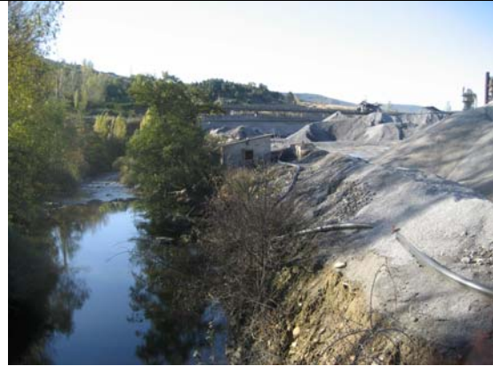
Ribera del Arga a la altura de la industria de Magnesitas de Navarra. Afecciones a la ribera. Se está llevando a cabo un proyecto de restauración de la misma
