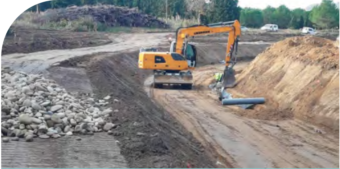
Excavaciones en emisario La Sotonera
