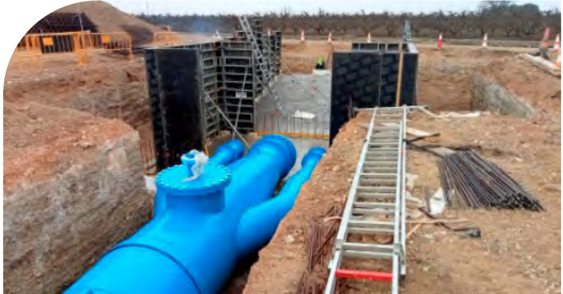
Arqueta vertido pieza pantalón Acequia La Mola
