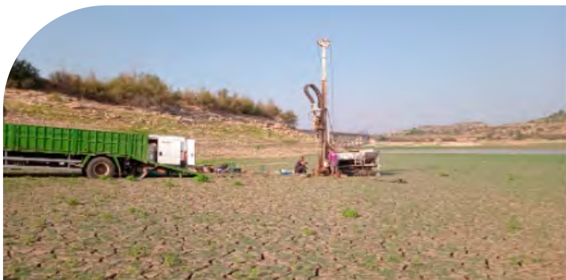
Sondeo S-14 Embalse de Mequinenza a la altura de Caspe.
