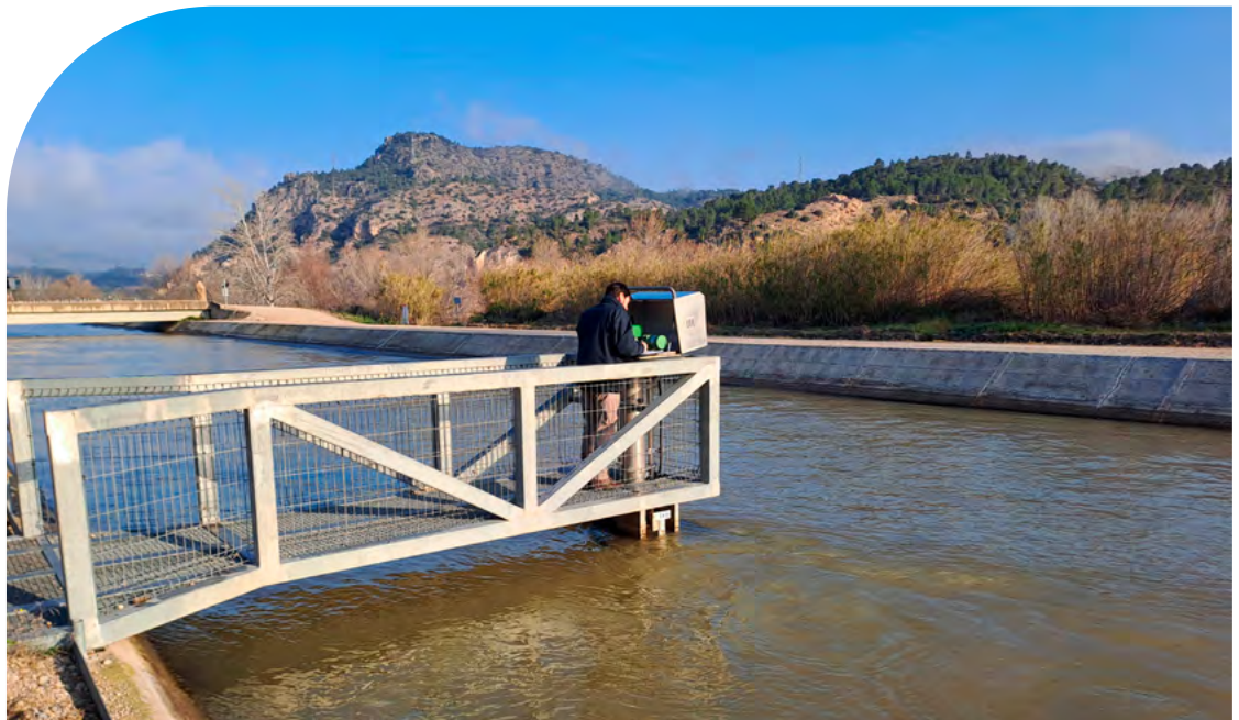
Estación de aforos en canal de Xerta Derecha
