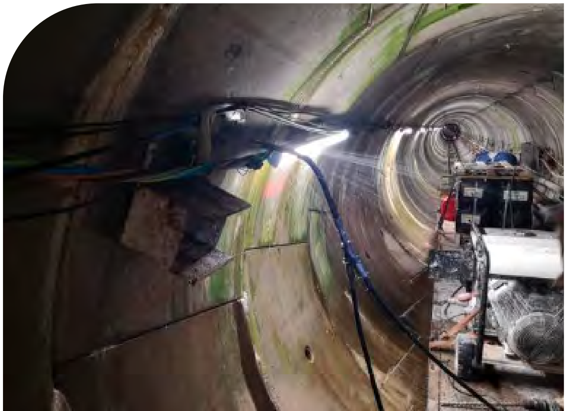
Interior túnel hidráulico Jalón - Grío
