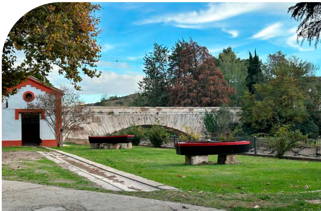
Espacio patrimonial de El Bocal (Fontellas, Navarra)
