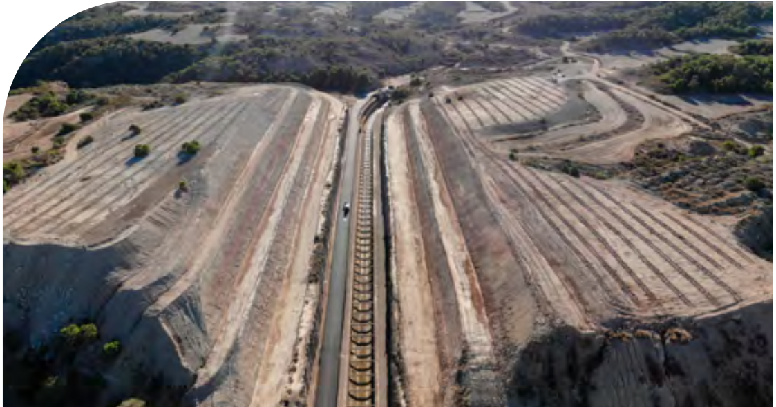
Vista aérea trinchera Alcuérrica
