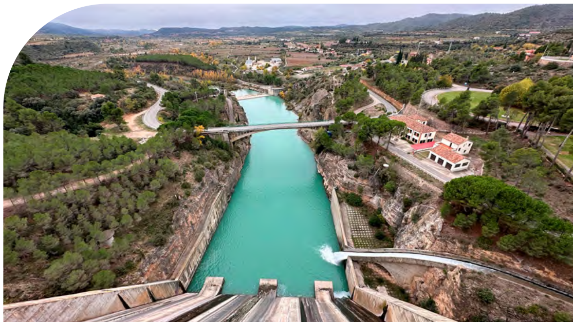
Vista desde la coronación de la presa de El Grado
