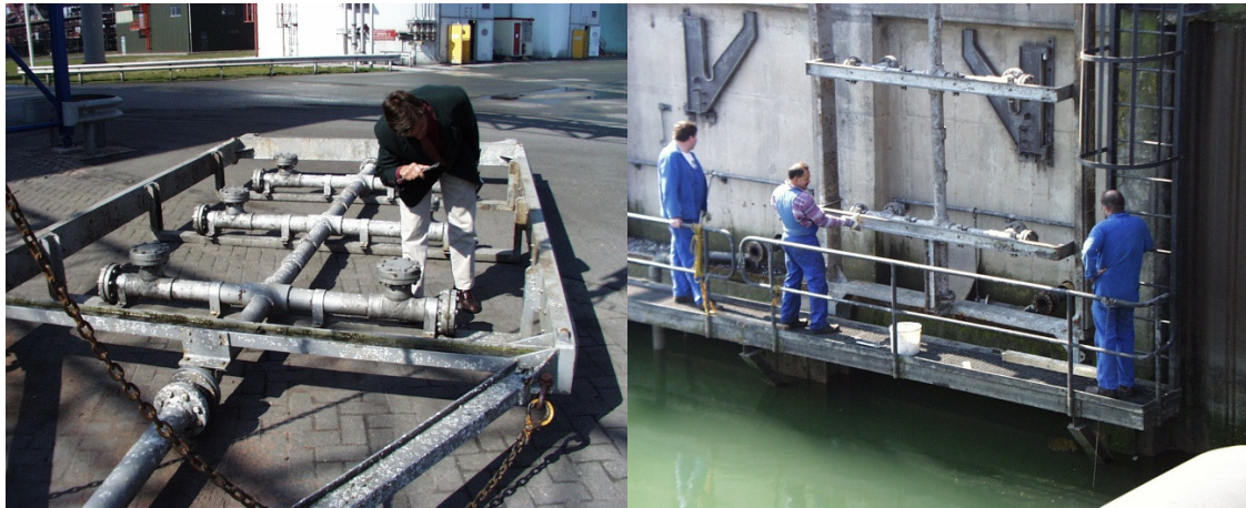
Figura 13 Rejilla dosificadora en la central eléctrica de Maasvlakte
