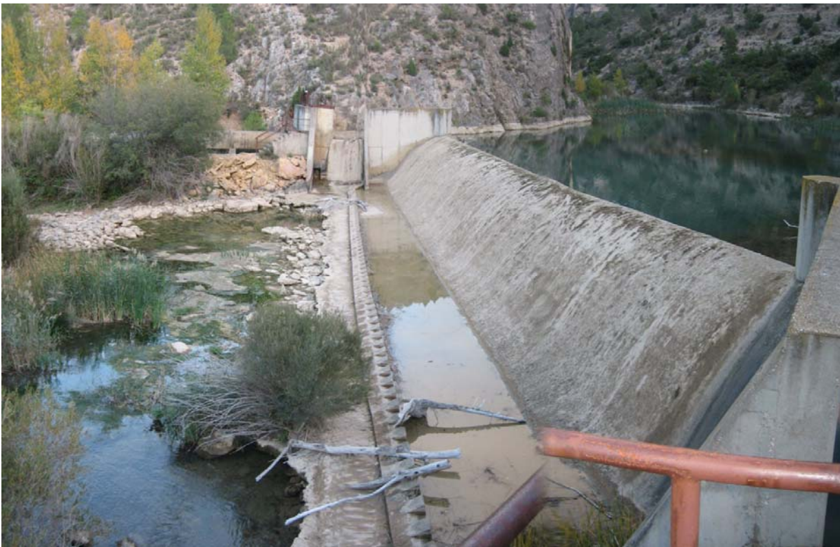
Fig. 3. Vista hacia la margen derecha del obstáculo a permeabilizar
