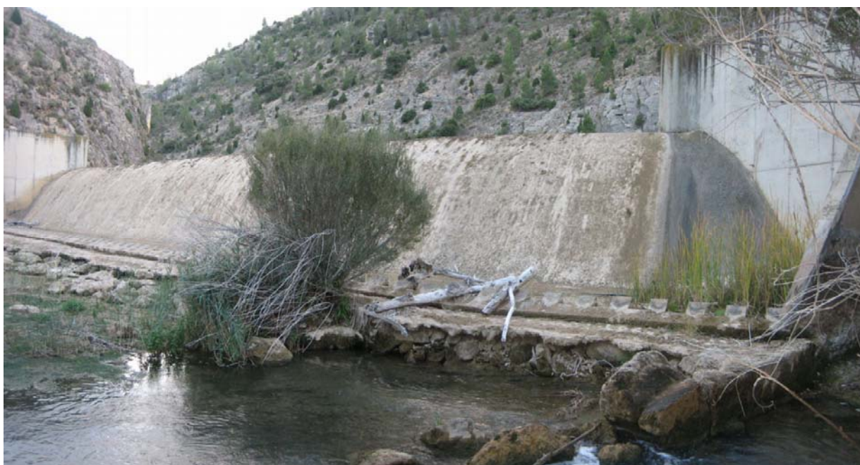
Fig. 4. Vista frontal de la estructura a permeabilizar para el paso de los peces
