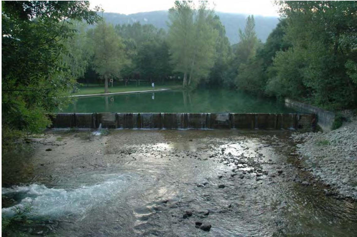
Foto 9. Estación CEMAS 0815 en le río Urederra no muestreable por la presencia de la piscina fluvial.
