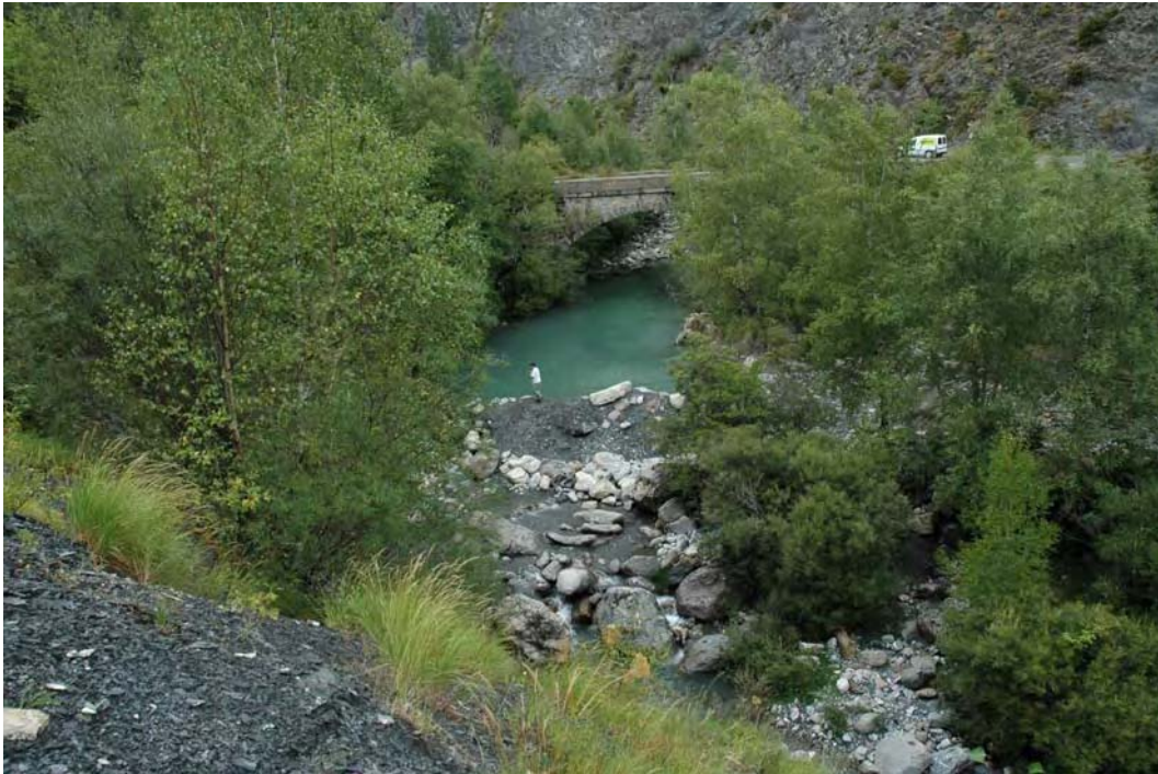
Foto 3. Estación CEMAS 2199 (río Escarra en Escarrilla) inundado por la represa creada.
