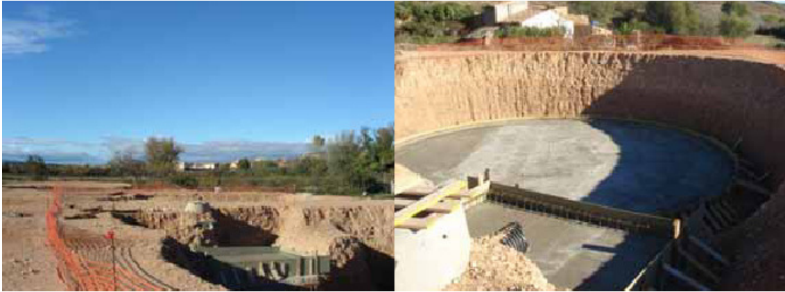
Construcción de EDAR (de fangos activados) en Azuara.
