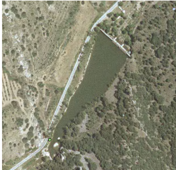
Azud localizado aguas abajo de la estación 637
