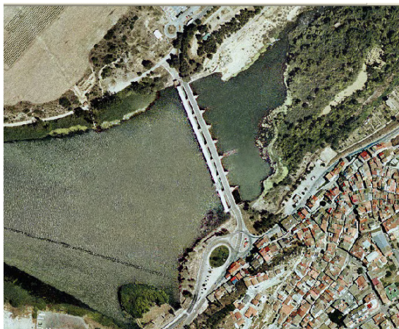
Presa de Flix en la cola de la masa con central hidroeléctrica.
