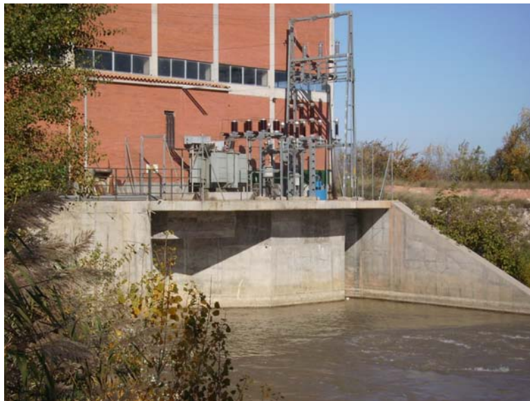
Central Hidroeléctrica de Velilla II
