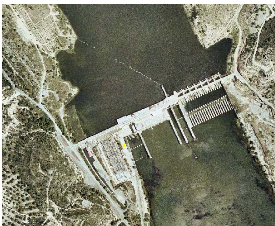
Presa de Ribarroja en la cabecera de la masa con central hidroeléctrica
