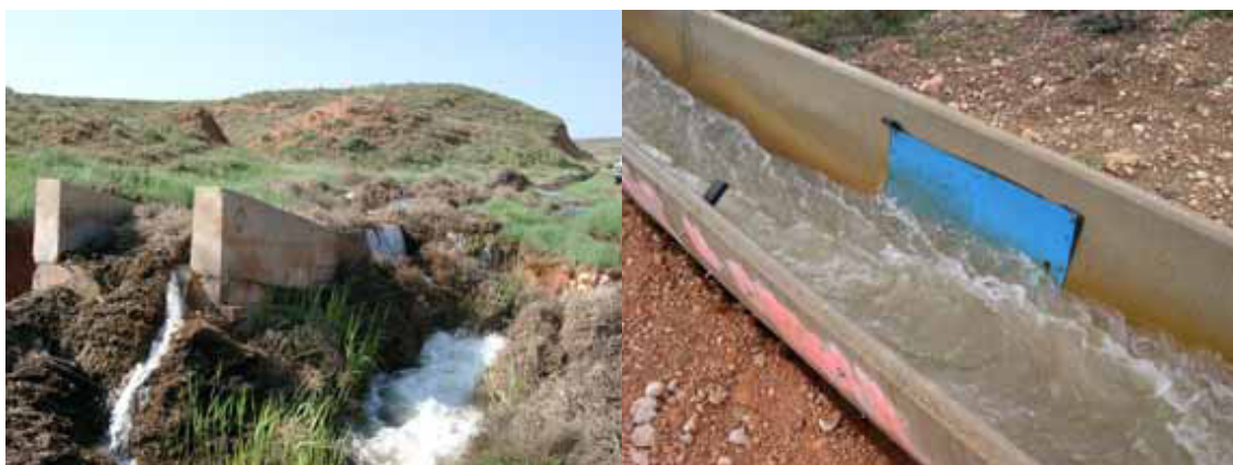
Aprovechamientos para riego del canal alimentador del embalse de Moneva (T.M. Moneva)
