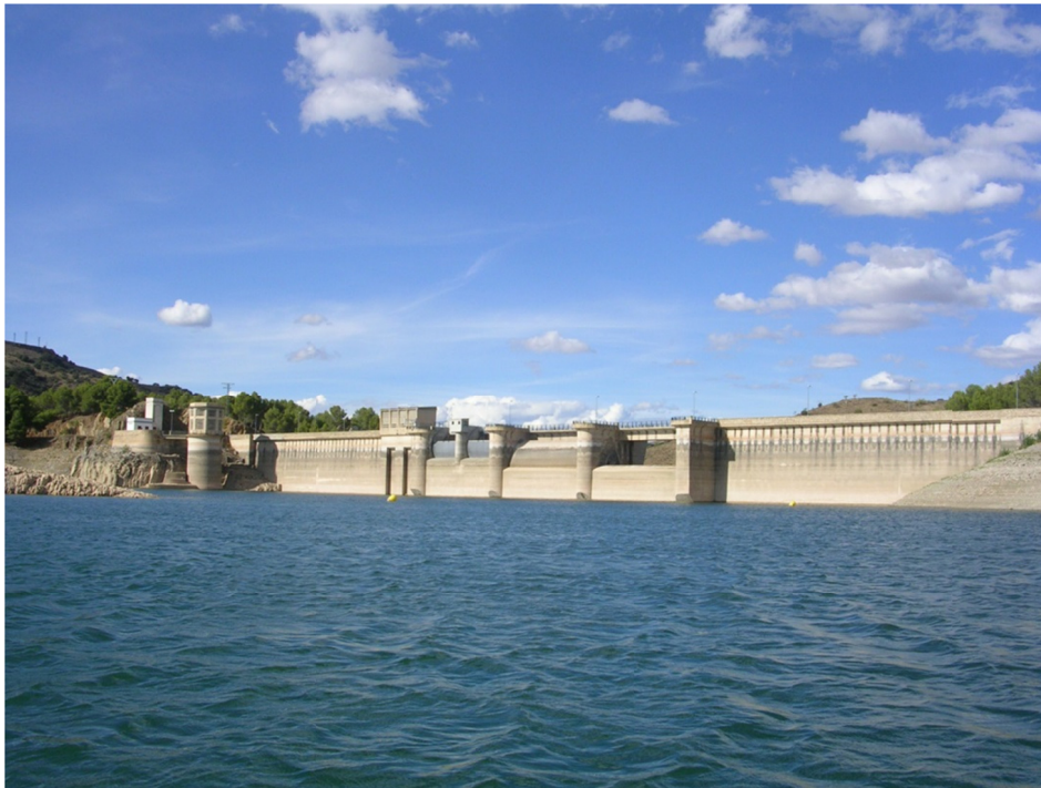
Figura 7. Vista de la presa del embalse
