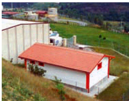
Imagen 12. Depósito de Erletxes en el tramo Venta Alta – San Vicente
