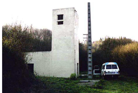
Bombeo al Depósito de Artxanda
