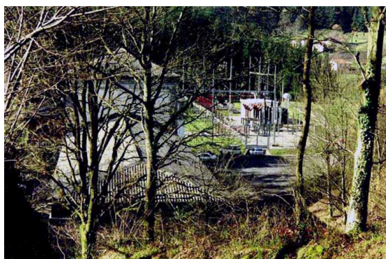
Imagen 4. Central Hidroeléctrica de Barazar
