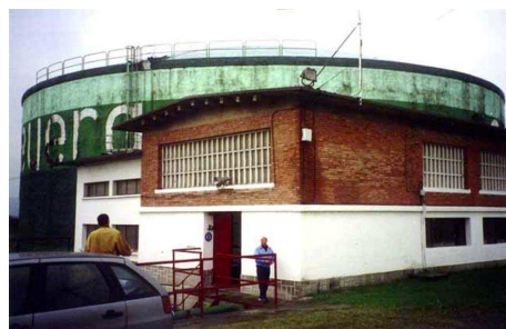
Depósito de Portugalete (La Florida)
