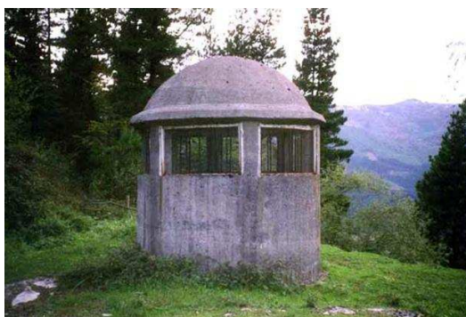
Imagen 5. Chimenea de equilibrio en el túnel del Salto de Barazar
