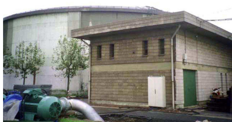
Depósito de Rontegi
