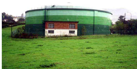
Depósito de Las Carreras
