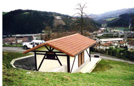
Bombeo al Depósito de Goikiri
