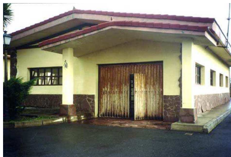
Depósito de Gambe
